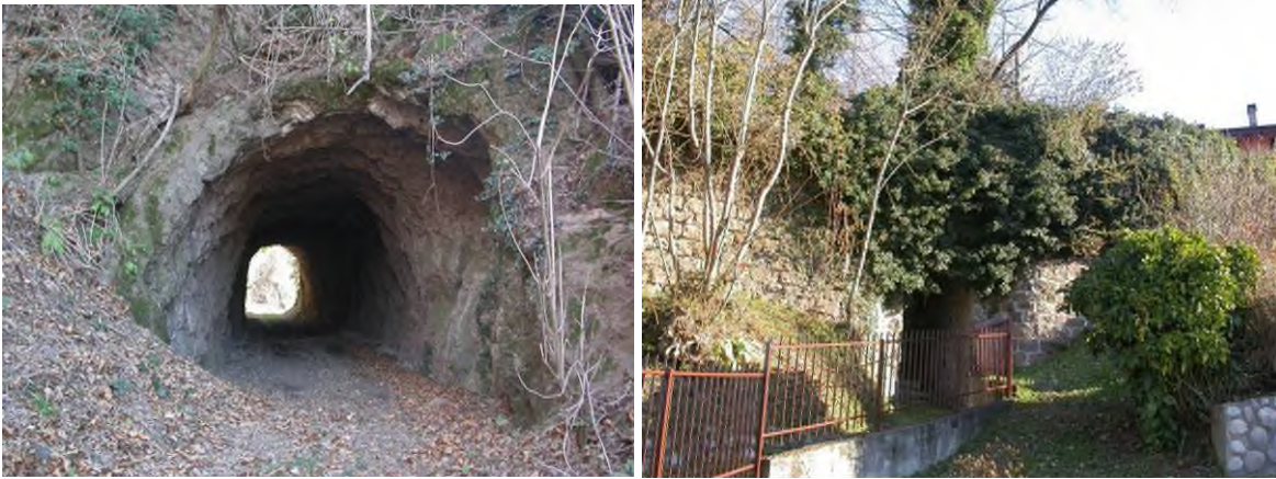
Sopra, recupero di manufatti della vecchia tramvia lungo un possibile itinerario pedonale.
